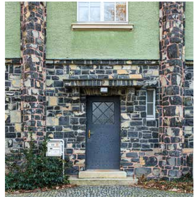
Abb. 6 | Steinsburgmuseum Römhild, Teilansicht der west- lichen Seitenfassade; 2024
